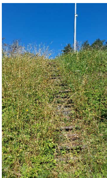
12 pav. Šlaitinių laiptų pakopų betonas aptrupėjęs, apsamosojęs, laiptai kreivi, nėra turėklų
