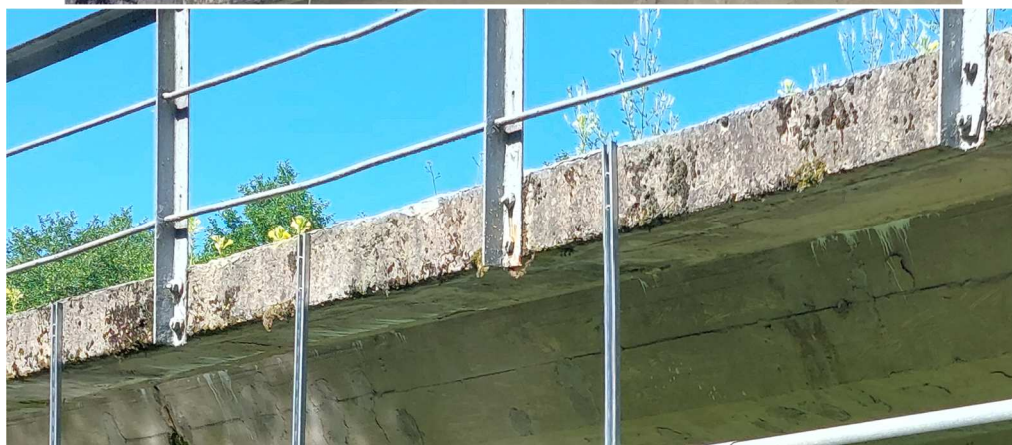
4 pav. Šaltilčių betono paviršius apsamojęs, nutrupėjęs betonas
