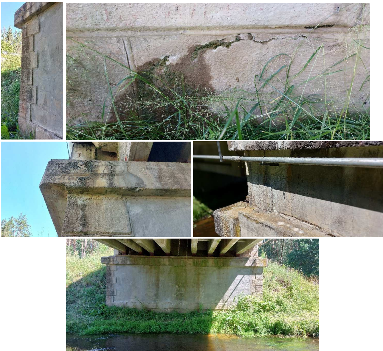
11 pav. Ramtuose vietomis nutrupėjęs betonas, nuolat drėkinami, atšokęs apsauginis sluoksnis
