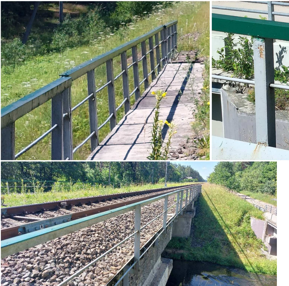
5 pav. Turėklai kreivi, nesutampa ašys, koroduoja plieniniai elementai
