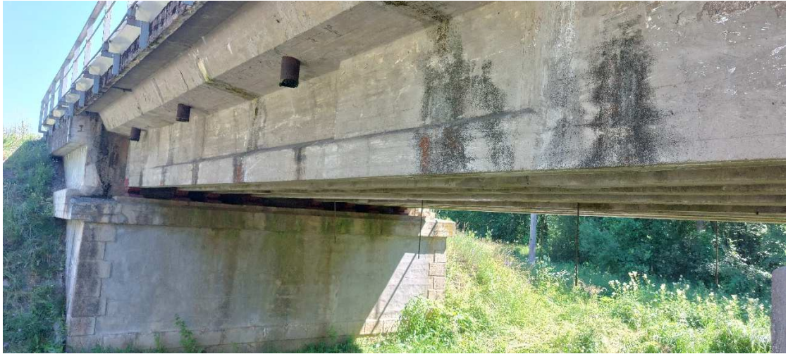
7 pav. Hidroizoliacija nesandari. Ant plokščių ir sijų matomos vandens pratakos, metalo korozija, karbonizacija.
