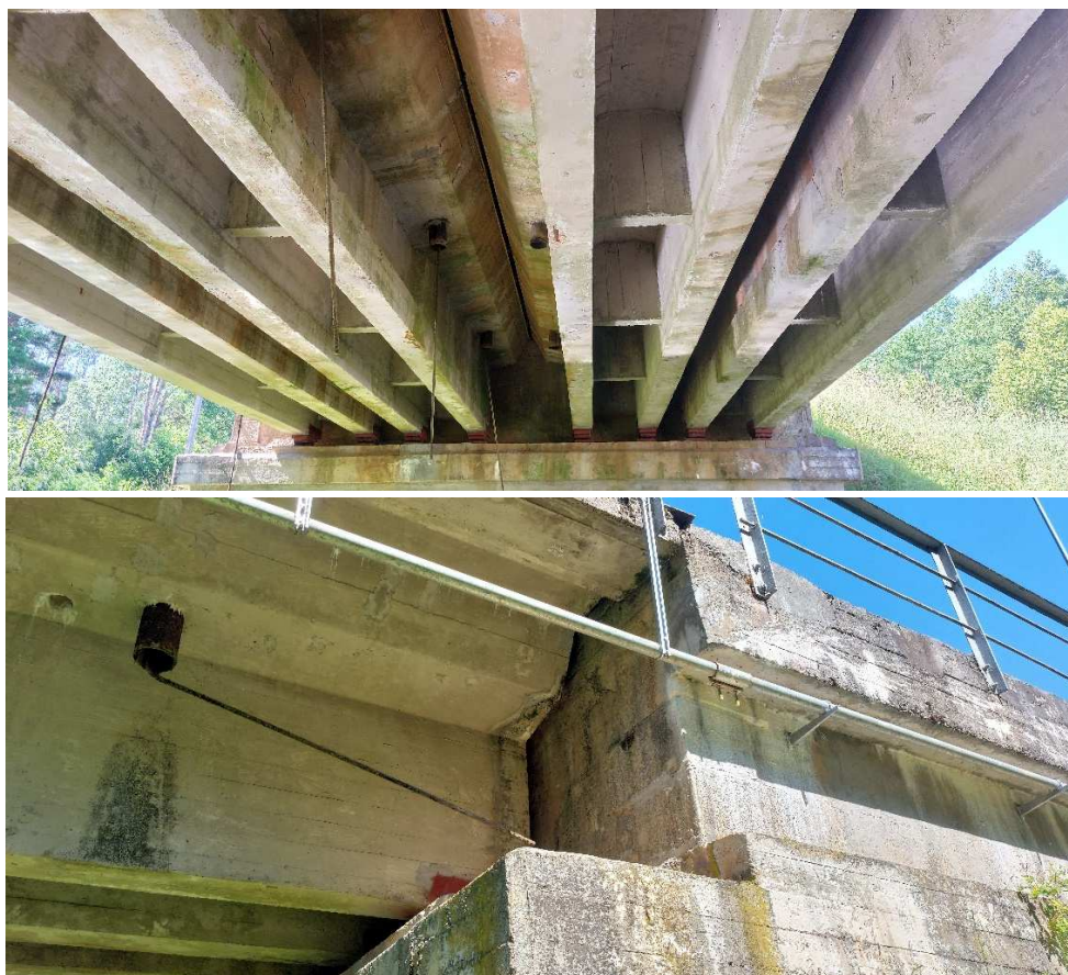
9 pav. Sijos yra pasidengusios apnašomis ties šulinėliais, nuolat drėkinamos, vietomis atšokęs apsauginis sluoksnis, matosi išlindusi armatūra, vietomis ties atramomis atsivėrę plyšiai
